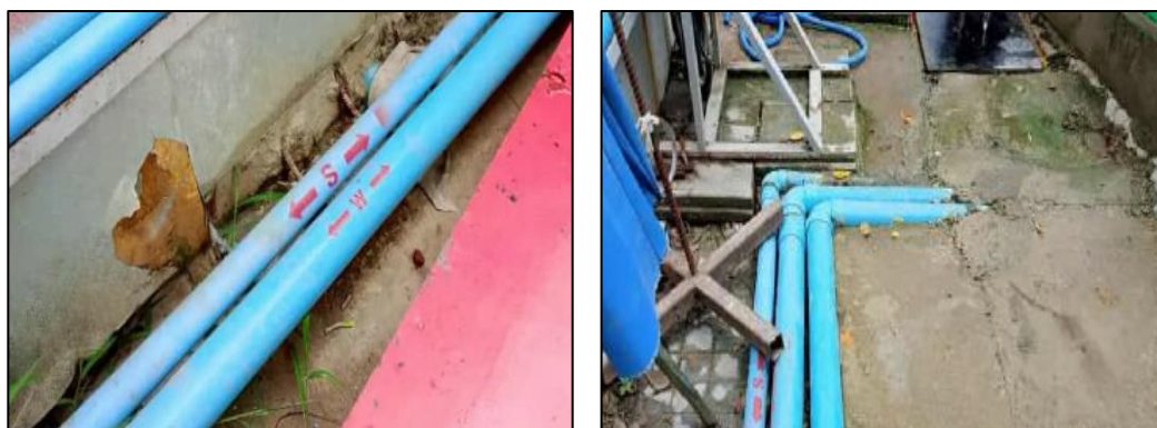
รูปที่ 1-6 ท่อระบายน้ำชั่วคราวรอบบริเวณพื้นที่โครงการ
