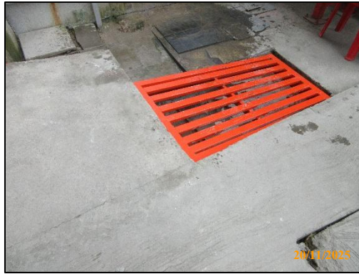
รูปที่ 1-7 ตะแกรงดักขยะบริเวณปากท่อระบายน้ำ
