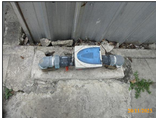
รูปที่ 1-5 ติดตั้งมิเตอร์น้ำประปาภายในพื้นที่โครงการ
