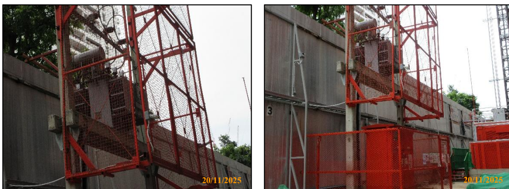
รูปที่ 1-10 หม้อแปลงไฟฟ้าก่อสร้างโครงการ
